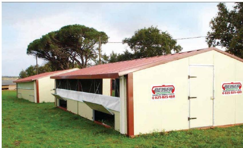
Ce type de bâtiments est en panneaux sandwich, avec claires-voies et trappes pour parcours, installation de panneaux solaires sur le toit assurant l'éclairage et le chauffage si nécessaire.
